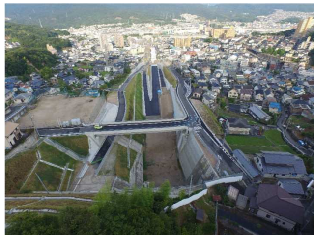
写真② 中山出入路周辺(H30.8時点)
